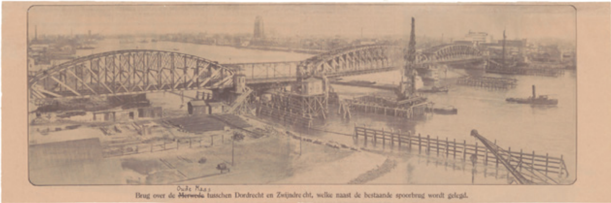
De fundamente van de pijlers worden gelegd naast de pijlers van de spoorbrug. Binnen de damwanden worden de palen eerst geheid en vervolgens geschroefd. RAD, Gemeentelijke prentenverzameling, inv.nr. 552_131339.
