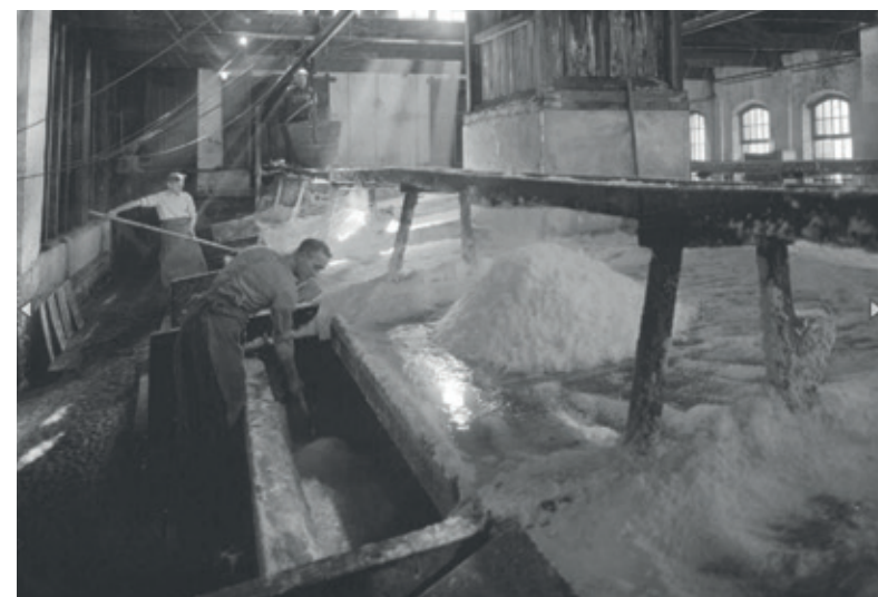
Zoutbereiding in de open pannen van de Zwiindrechtse keet. Foto, twintigste eeuw. Collectie Museum de Vergulde Swaen.
