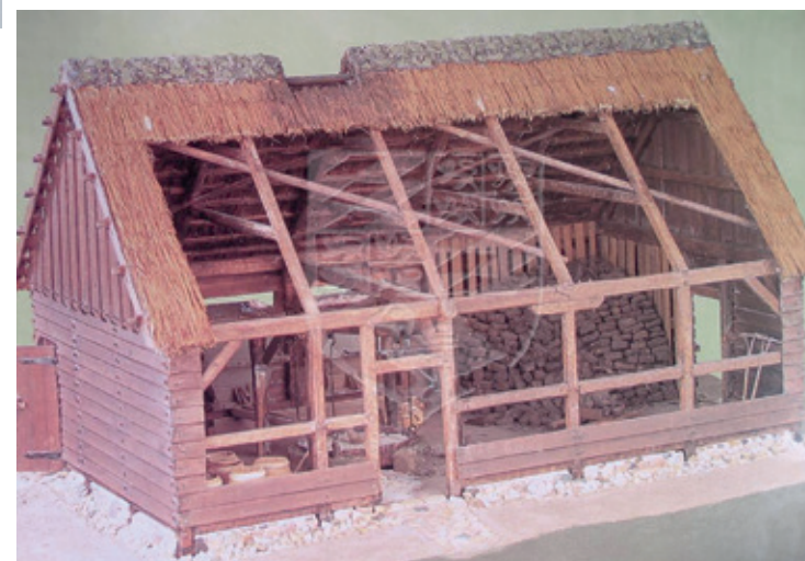
Maquette van een achttiende-eeuwse zoutkeet in Noord-Duitsland. Duidelijk te zien is het vierkante gebouw met puntdak en het grote gat in het dak. De zoutpan(nen) zijn hier links geplaatst en rechts is de turfopslag.
