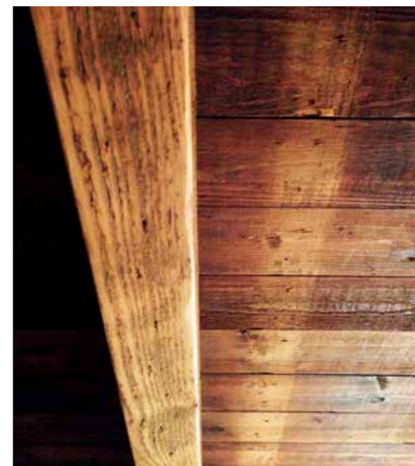
De planken van het plafond in het onderhuis. Duidelijk aan de lichte plekken te zien is waar in het verleden de balken hebben gezeten. Collectie schrijver.
